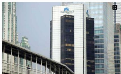
Pekan kali melintas di dekat gedung Wisma Bumiputera di Jakarta. Bisnis
